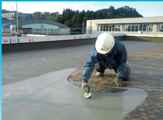
仮防水材 一刻(ひととき)は、EVA樹脂(エチレン酢酸ビニル)を主成分としたポリマーセメント系の下地調整材兼仮防水材です。既存の防水材を撤去した後、一時的に建物へ雨水の侵入を防ぐことができます。下地調整材と仮防水材を兼用しているため、改修工事におすすめです。
