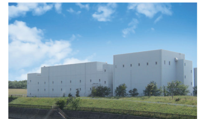
茨城県利根川浄水場
