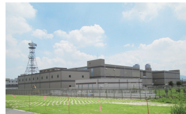
大阪府庭窪浄水場
